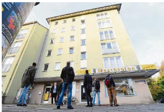
In diesem Haus ist die Wohnung, für die sich 600 Menschen interessiert.
