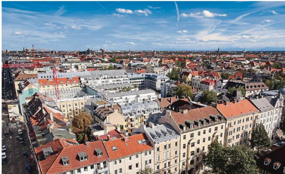
Mieter in attraktiven Städten (im Bild Luftaufnahme von München) könnten durch die Grundsteuerreform belastet werden. Den Eigentümern macht eher die individuelle Berechnung jeder Wohnung Kopferbrechen. FOTO: IMAGO
