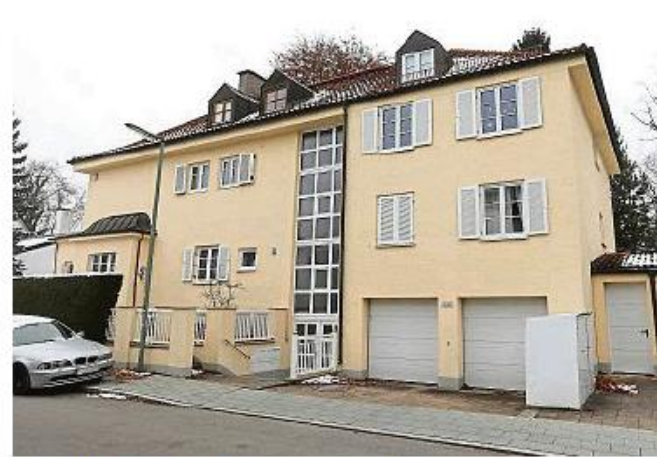
Das Haus in der Rottenbucher Straße in Sendling ist seit vier Generationen im Familienbesitz.
