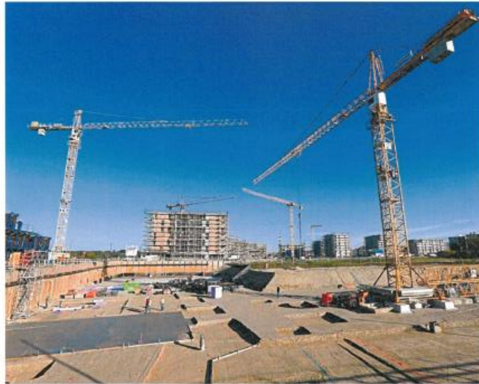
Die Stadt will ein größeres Stück von Baugebieten: Unser Bild zeigt Arbeiten in Freilham im November 2019. FOTO: REHLE
