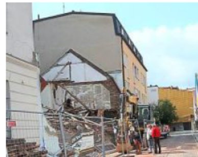
Der Abriss des Uhrmacherhäusls in Giesing hat 2019 viele erzürnt.
