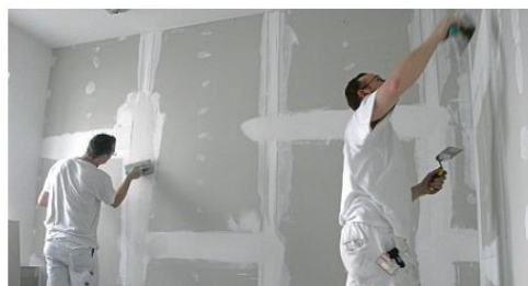
Männer verspachteln eine Rigips-Wand. Wird die Bausubstanz verändert, sollten Mieter eine Genehmigung einholen. Streichen gehört zu Schönheitsreparaturen
