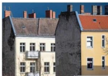
Auf Mietshäuser aus der Nachkriegszeit könnten laut Haus & Grund Sanierungskosten in Höhe von 400 000 bis 800 000 Euro zukommen. FOTO: M. SKOLIMOWSKA, DPA
