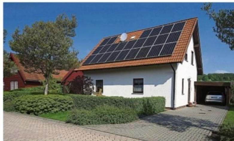
Das kann den Strom-Ertrag mindern: ein Baum vor einem Haus mit Photovoltaik-Anlage.
