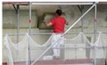
Bessere Dämmung: Arbeiter saniert Haus. IMAGO
