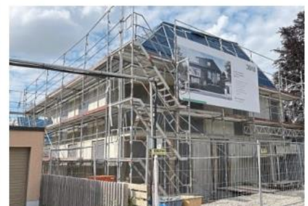
Der Rohbau für das „Effizienzhaus“ in der Ittisstraße (Waldtrudering) steht seit Juli 2022. Fünf Familien sollten hier einziehen.
