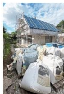
Ein halb fertiges Zweifamilienhaus der Firma 3 Bau in der Ittisstraße.
