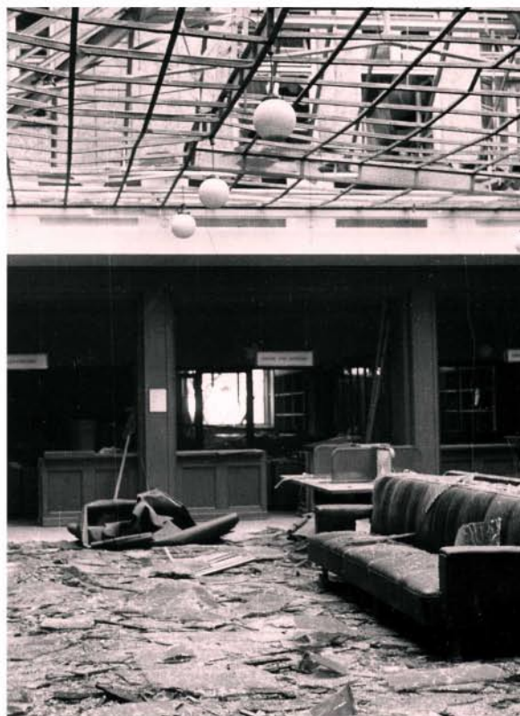
Die Schalterhalle nach dem Luftangriff vom 19./20.9.1942
